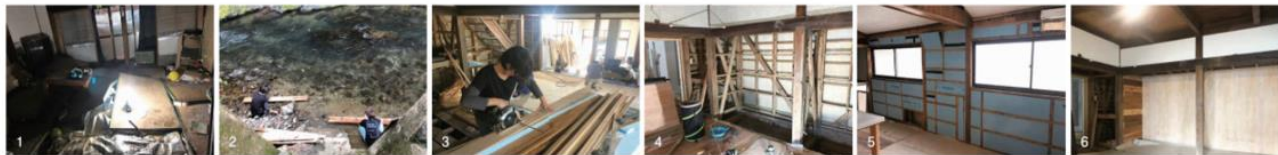
1. 熊本・坂本で床上浸水した民家の改修。改修前の様子。生活再建の方向性が定まらないなか建て主とやり取りしながら工事範囲を決めていく 2. 再利用する板材を川で洗うところから工事は始まる 3. 加藤さんをアシストする女性のコミュニティ大工。実は根占の古民家の建て主。大工技能は習得過程だがコミュニケーション能力に長けている 4. 床上浸水により傷んだ壁仕上げなどを撤去して再度つくり直す 5. 壁を合板で塞いだところ。今後の家の使い方が定まっていないので、費用を抑えてつ居住環境を整える方法を採用した 6. 既存の柱や間柱、脚柱の間に断熱材を詰めていく。手間は掛かるが作業的には特別の技能を要しないのでワークショップ向きの作業
